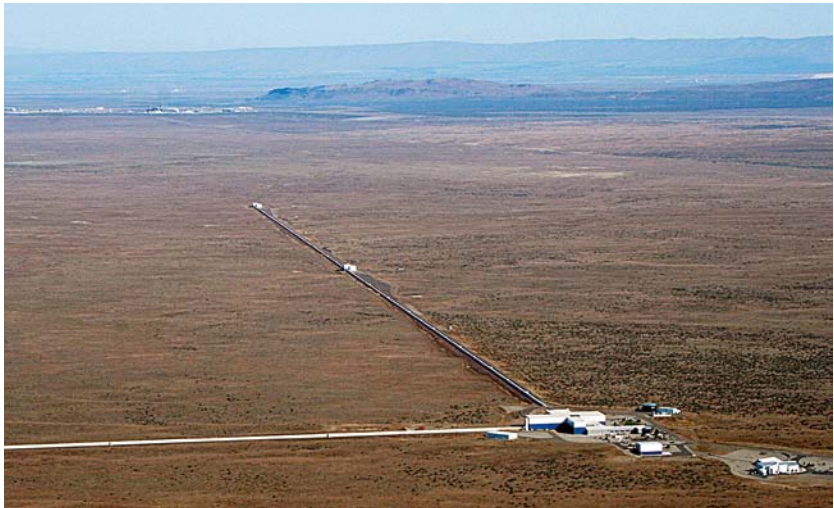
VISTA AÉREA de las instalaciones de LIGO en Hanford, en el estado de Washington. La fotografía muestra los dos brazos del interferómetro, de cuatro kilómetros de longitud.
