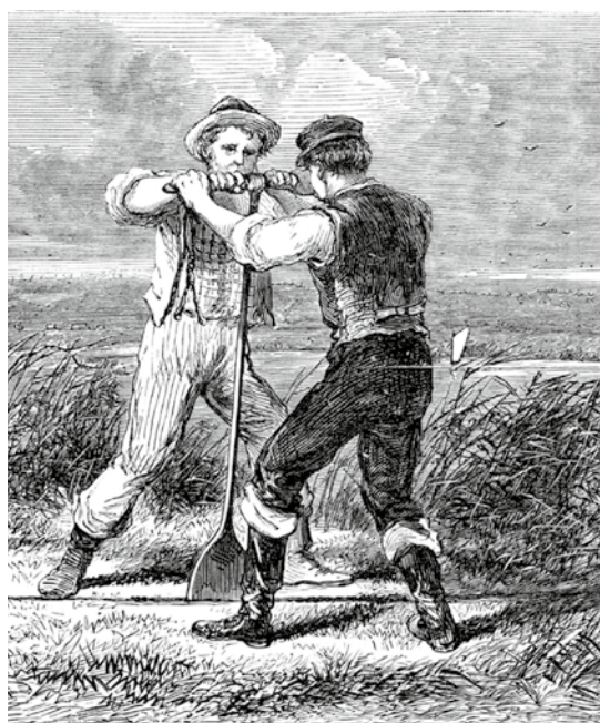
1868: En Nueva Jersey, dos operarios instalan planchas de hierro por «escopleado» del terreno para facilitar el avenamiento del mismo.
