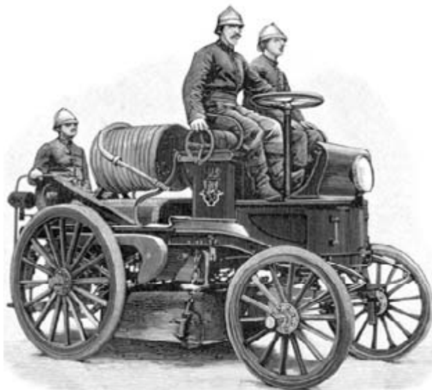
Bomba de incendios eléctrica. París, 1900
