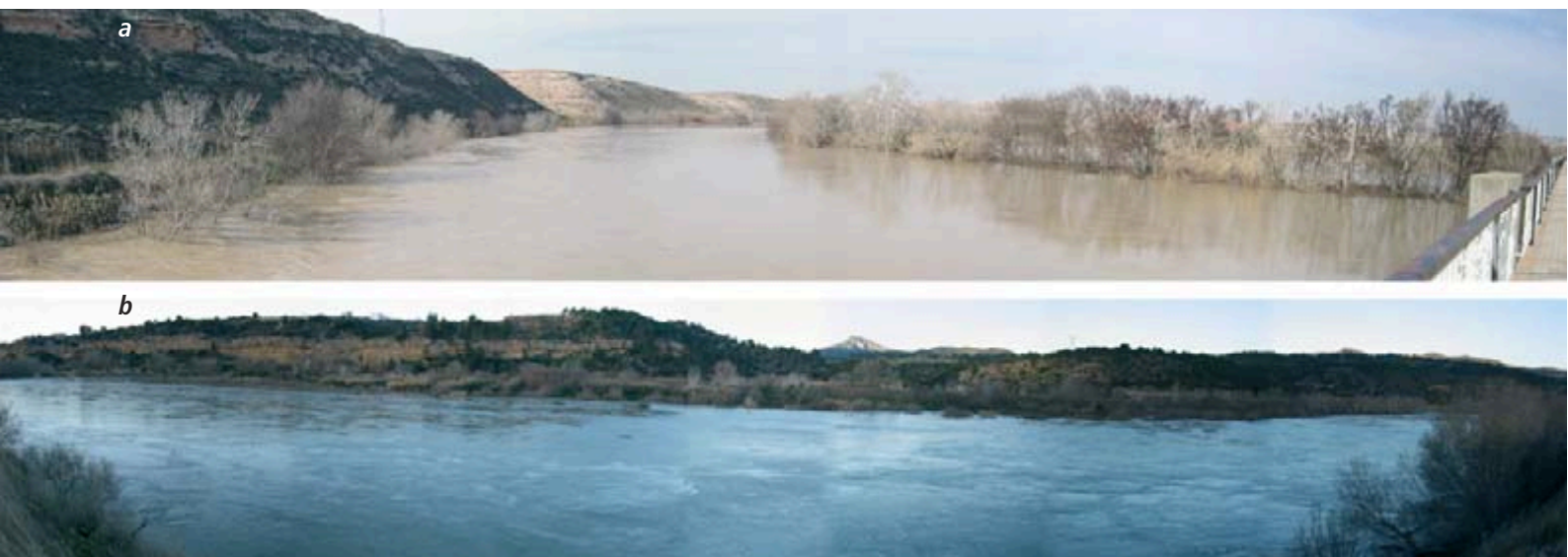
1. El río Ebro a su paso por (a) Sástago (aguas arriba del embalse de Mequinenza) y (b) Mora de Ebro (aguas abajo de la presa de Flix), durante episodios de crecida. La diferencia de color del agua muestra la reducción del transporte de sedimentos.
