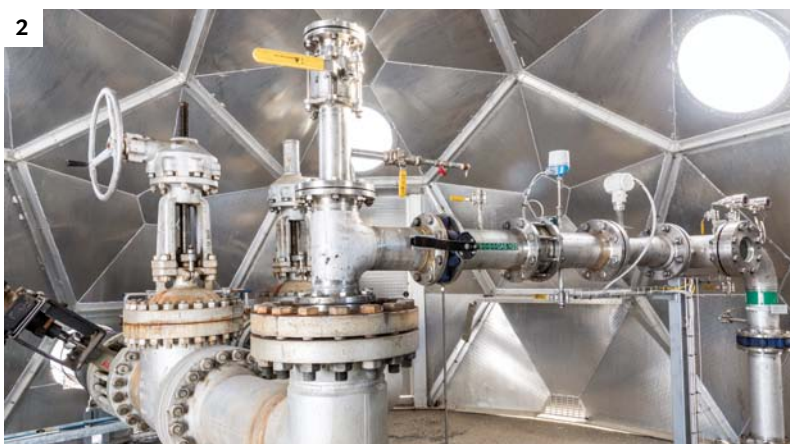
UNA MÁQUINA de la compañía Climeworks extrae dióxido de carbono de la atmósfera (1). Dentro de una cúpula cercana, un inyector (2) envía el gas a más de 700 metros de profundidad, donde al reaccionar con el sustrato forma carbonato, visible como vetas blancas en la muestra fotografiada (3).
